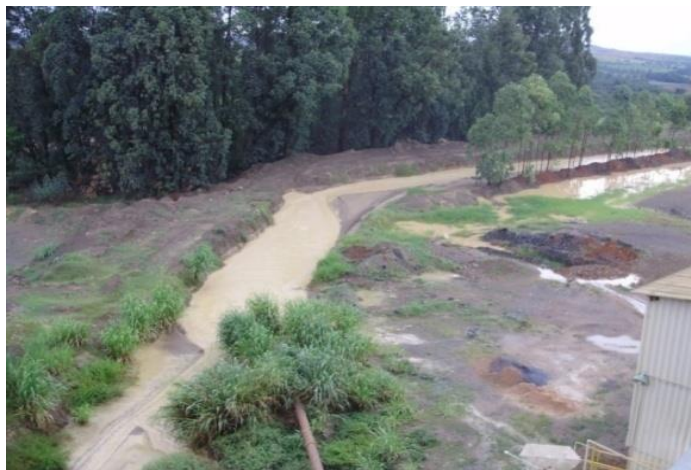
Figura 3. canal pelo qual a água da usina sendo conduzido por efeito da gravidade para ser acumulada no Corpo B.
